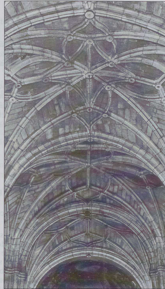
Detalle de las bóvedas.
